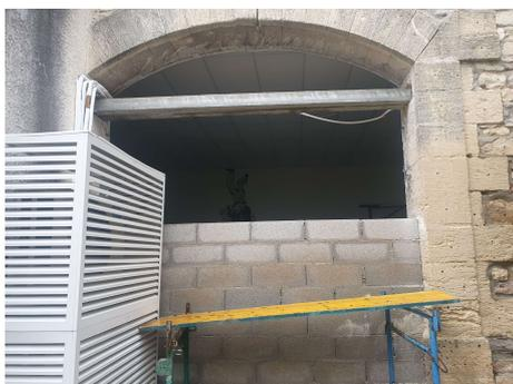
La salle de judo est aussi en travaux : un châssis fixe, double vitrage sera posé et financé par les fonds restants du « judo club du Mouressipe », ce qui permettra à la salle d'être bien ajourée. Le mur situé dans le ceintre de l'ancien portail sera reconstruit et doublé d'isolant pour le confort de nos sportifs...
